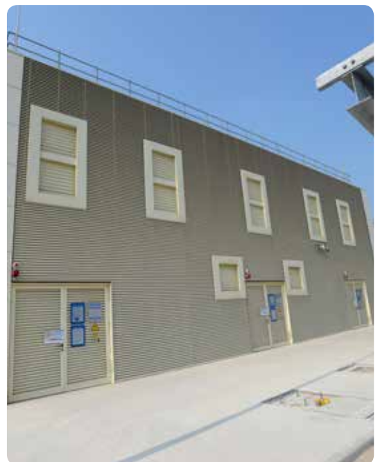
Ref. Terminal méthanier de Dunkerque, Loon-Plage (F), L.066.06
